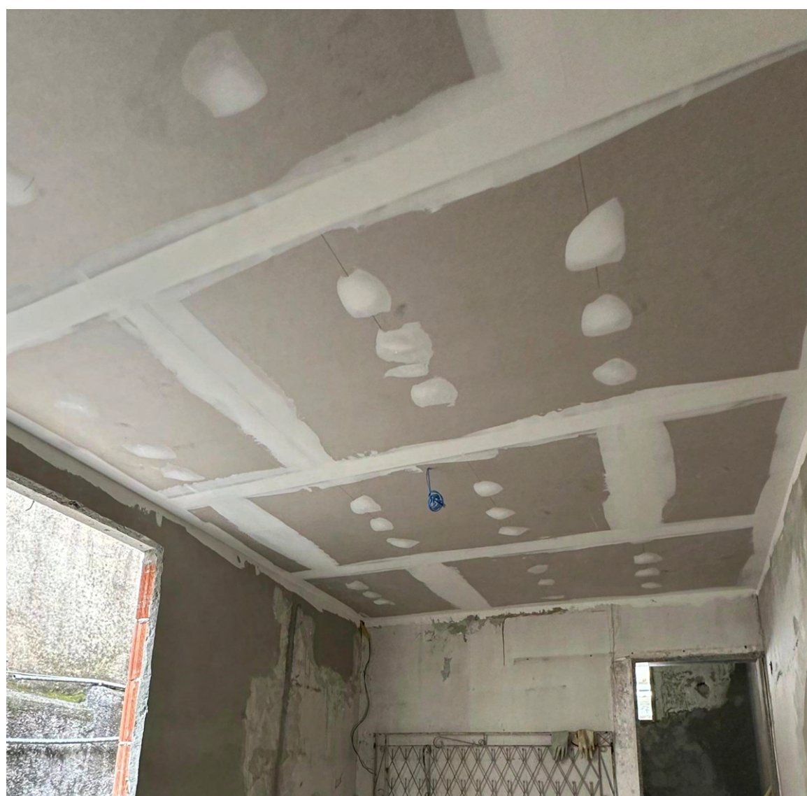
Instalação de forro em drywall em toda residência
