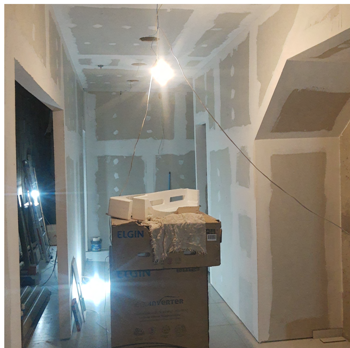
Instalação de paredes e forro em drywall
