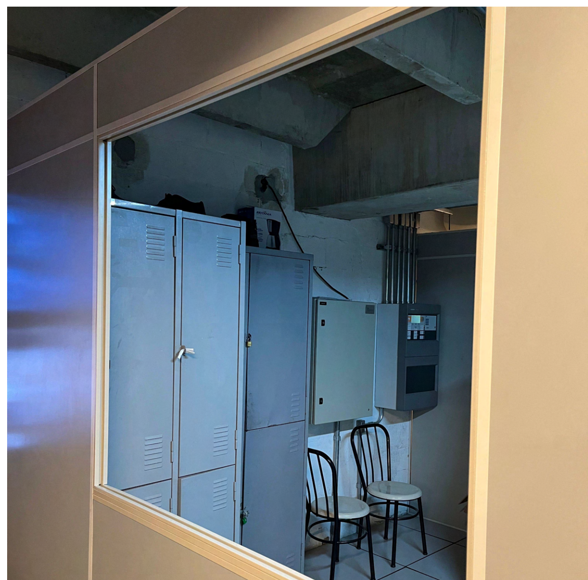
Manutenção de paredes Eucatex
